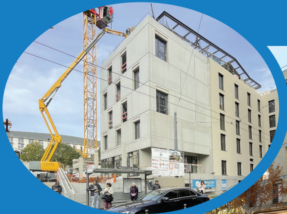
Photo des travaux de construction de la Maison Décembre 2024
